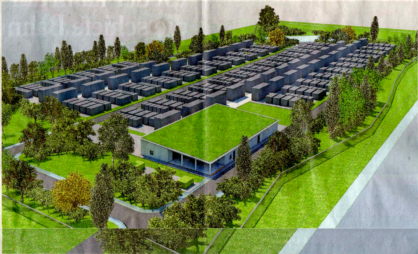
Bei einer gerichtlichen Anhörung im Herbst will die Kommune versuchen, den Bau der Kupferzeller Netzstabilisierungsanlage noch zu verhindern.
