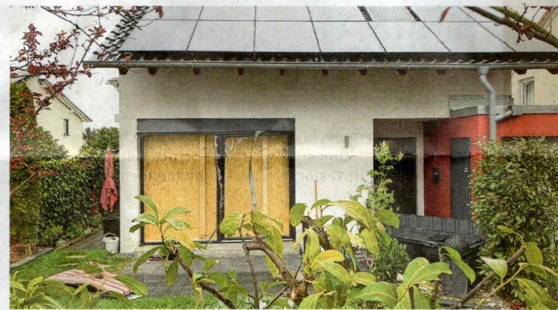
Die Feuerwehr Leingarten hat die Terrassentür mit Pressspanplatten verschlossen. Das Einfamilienhaus ist derzeit unbewohnbar.
